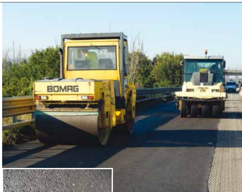
12A e 12B. La posa in opera: la fase di compattazione
