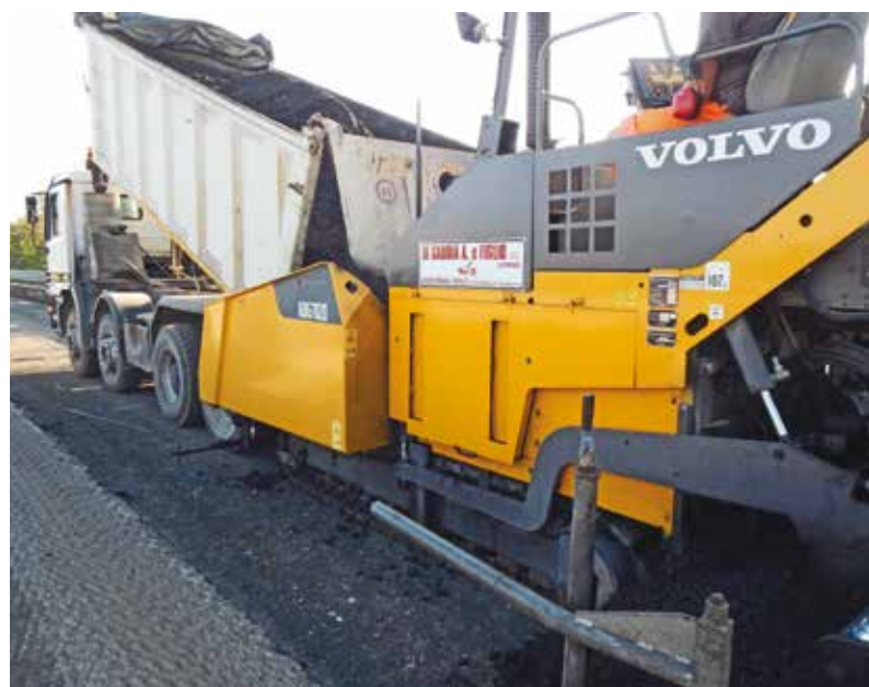
8. La posa in opera: la fase di stesa
