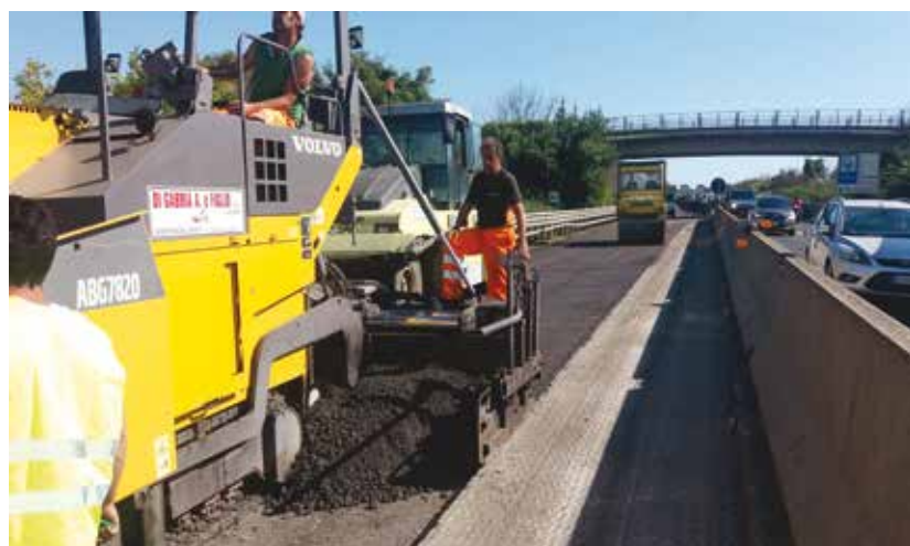
1. Per la posa in opera è stata redatta una PTO (Procedura Tecnico Operativa)
