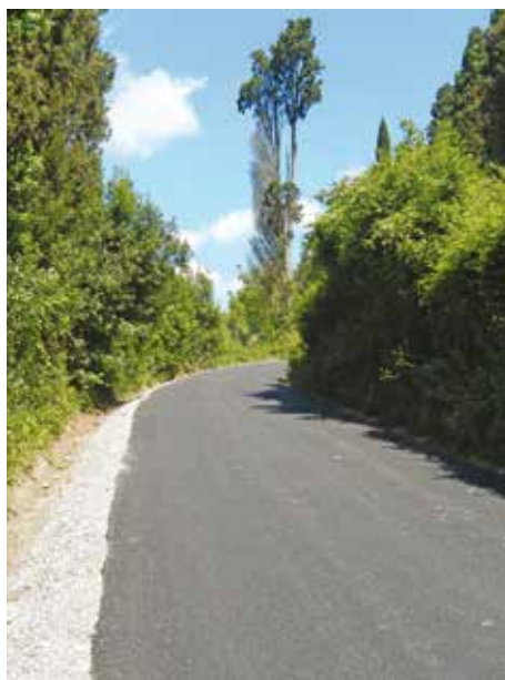
1A e 1B. Un diverso impatto ambientale prima e il dopo la posa in opera: con conglomerato bituminoso tradizionale (1A) e con trattamento superficiale (1B)
