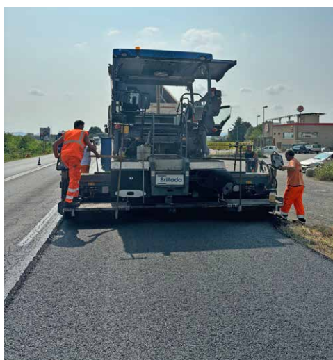
5A e 5B. Posa in opera del conglomerato bituminoso prodotto con bitume BITROAD N/R Plus. Grazie alla bassa temperatura di posa (110 °C in questo caso) si nota come vi è assenza di fumo durante la lavorazione, a beneficio oltre che per l'ambiente, anche per gli operatori addetti ai lavori
