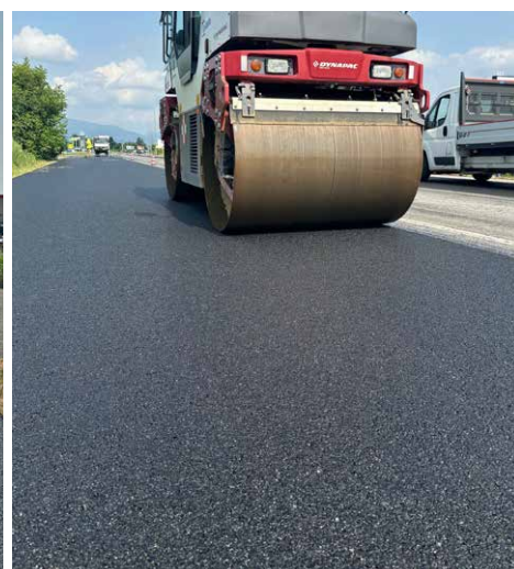
5A e 5B. Posa in opera del conglomerato bituminoso prodotto con bitume BITROAD N/R Plus. Grazie alla bassa temperatura di posa (110 °C in questo caso) si nota come vi è assenza di fumo durante la lavorazione, a beneficio oltre che per l'ambiente, anche per gli operatori addetti ai lavori
